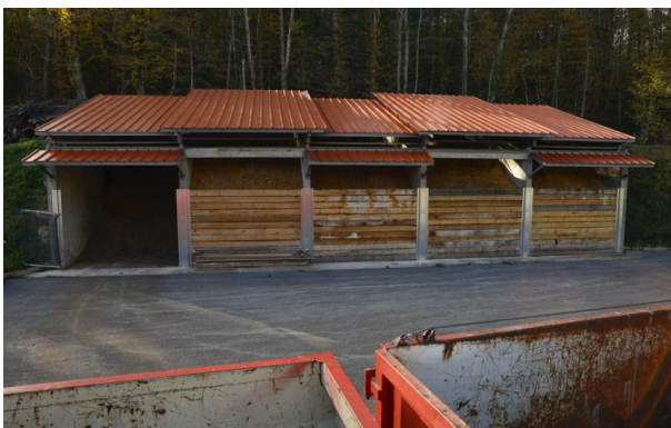
Saint-Laurent de Cerdans : le hangar de stockage des plaquettes forestières, implanté sur la déchèterie communale.
