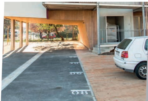
Accès pour livraison + silo
