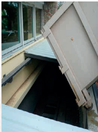
Remplissage du Silo
