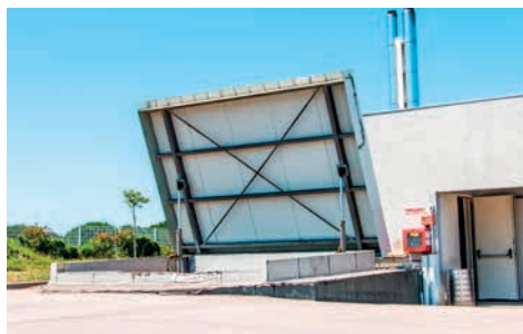
Trappe du silo
