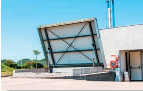
Trappe du silo
