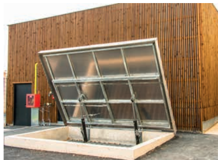
Silo enterré avec trappe basculante
