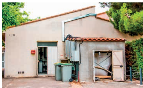
Local chaufferie et silo textile
