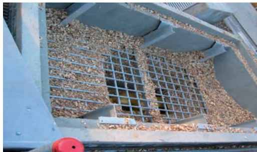
Trémie de chargement du silo enterré
