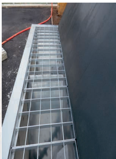
Trémie de remplissage du silo
