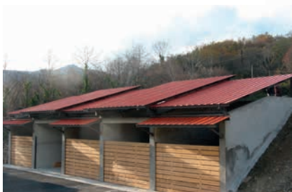
Hangar de stockage
