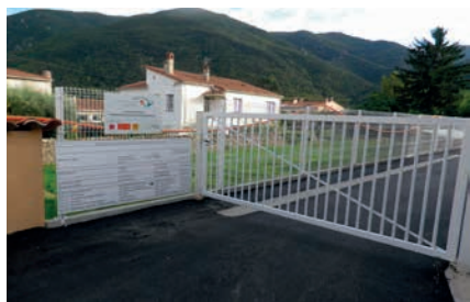
Voie d'accès de livraison
