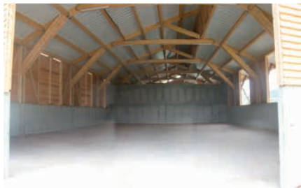
Vue intérieure du hangar
