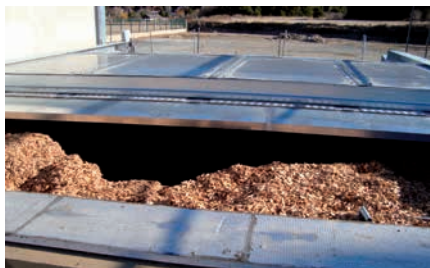
Silo semi-enterré avec capot coulissant
