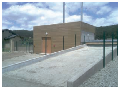
Local chaufferie et rampe d'accès au silo
