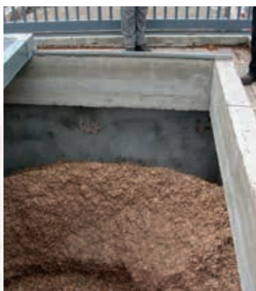
Silo semi-enterré fermeture par capot coulissant
