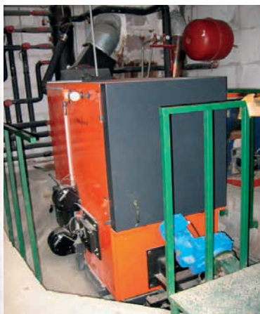
Chaudière Heizomat, 150 kW
