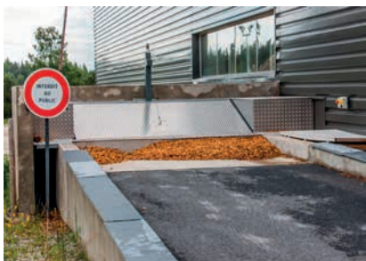
Rampe d'accès et trémie intermédiaire
