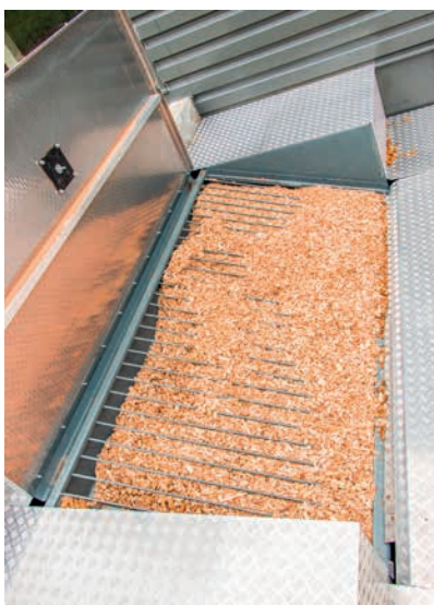
Trémie de remplissage du silo
