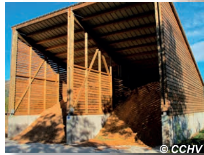
Hangar de stockage - La Bastide
