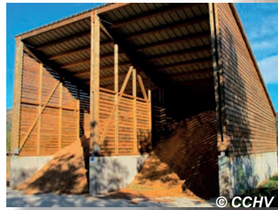
Hangar de stockage - La Bastide
