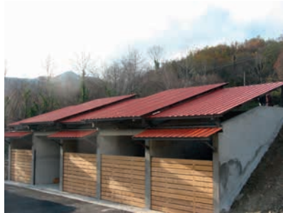
Hangar de stockage Prats de Mollo
