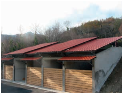
Hangar de stockage Prats de Mollo
