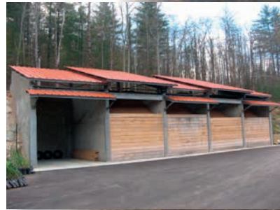
Hangar de stockage Saint-Laurent de Cerdans
