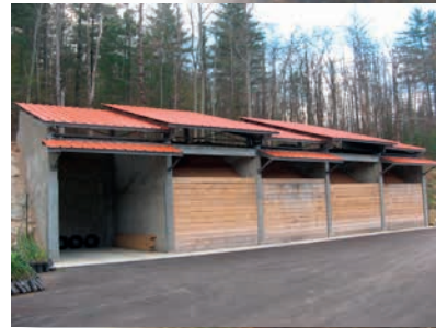
Hangar de stockage Saint-Laurent de Cerdans
