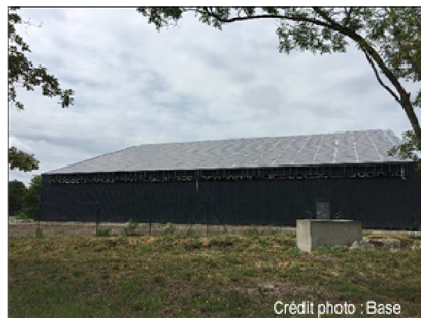
Figure 1 : Hangar de séchage avec toiture Cogen'air
