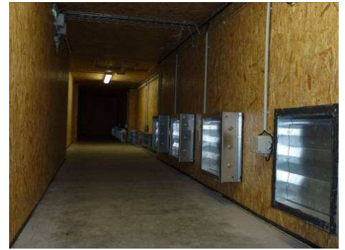
Figure 2 : Chambre de compression avec ses différentes ouvertures
