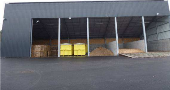
Figure 7 : Vue intérieur du hangar de stockage
